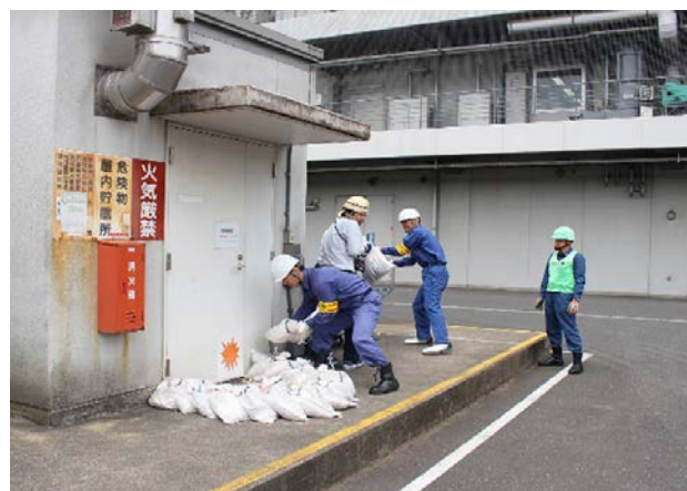
土嚢積みによる危険物漏洩流出防止措置
